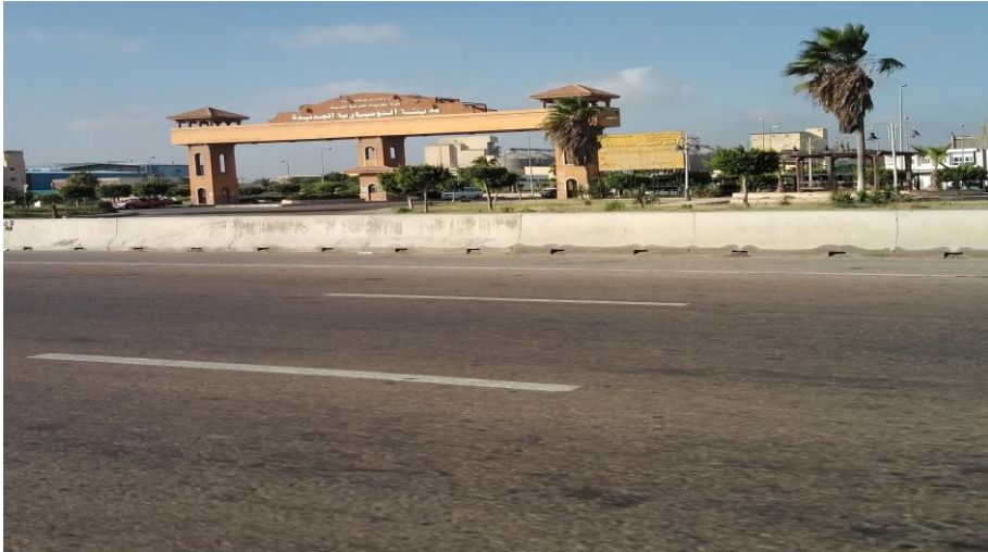
صورة (١) خنادق لتصريف مياه الأمطار على طريق القاهرة / الإسكندرية الصحراوى ، بتاريخ ٢٠٢٠/٨/١٤م. "ناظرا صوب الجنوب الشرقى".
